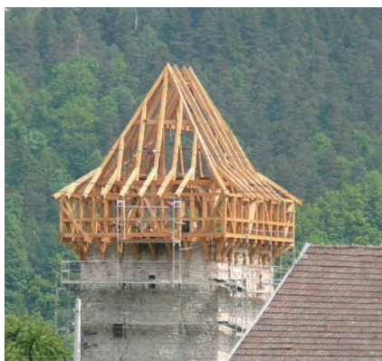
Hurdycja w trakcie rekonstrukcji
